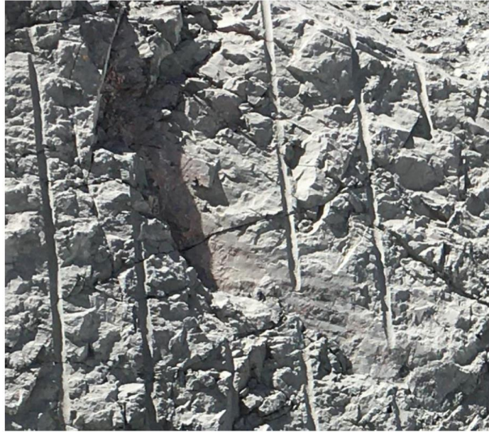
Figura 5.9- Grietas inducidas por tronadura Extraído: Área de Geomecánica, Minas El Romeral.
