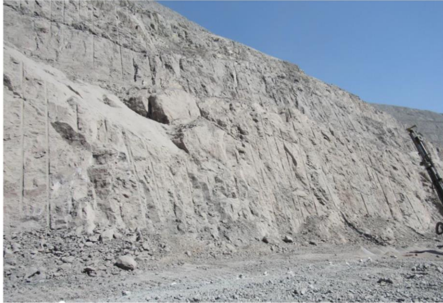
Figura 5.8- Fotografía que muestra medias cañas Extraído: Área de Geomecánica, Minas El Romeral.
