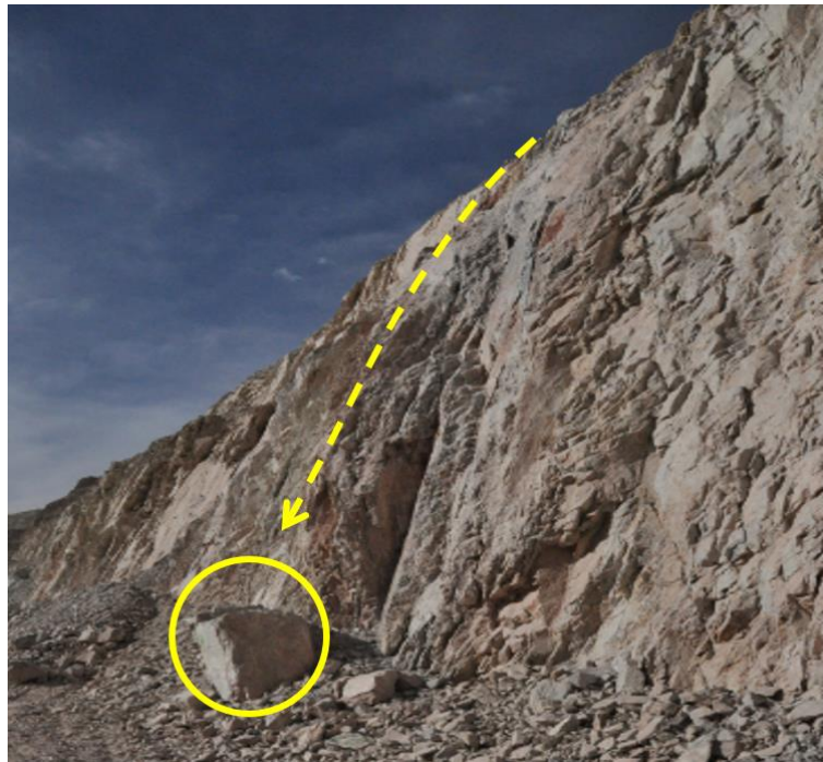
Figura 3.12- Fotografía caída de rocas in situ.
