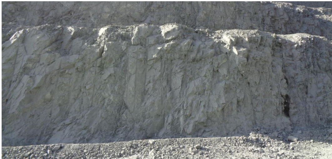
Figura 5.11- Geometría del talud Extraído: Área de Geomecánica, Minas El Romeral.
