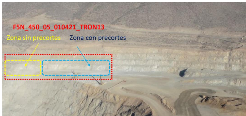
Figura 6.30- Fotografía que muestra sector tronado identificando zonas con y sin pre-cortes.
