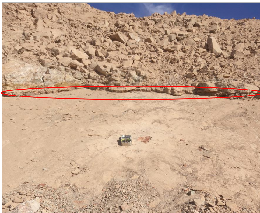
Figura 4.7. Plano de la estructura mayor de primer orden C en banco del nivel 1150 m.s.n.m., en donde la elipse de color rojo señala la zona de rellenos blandos.
