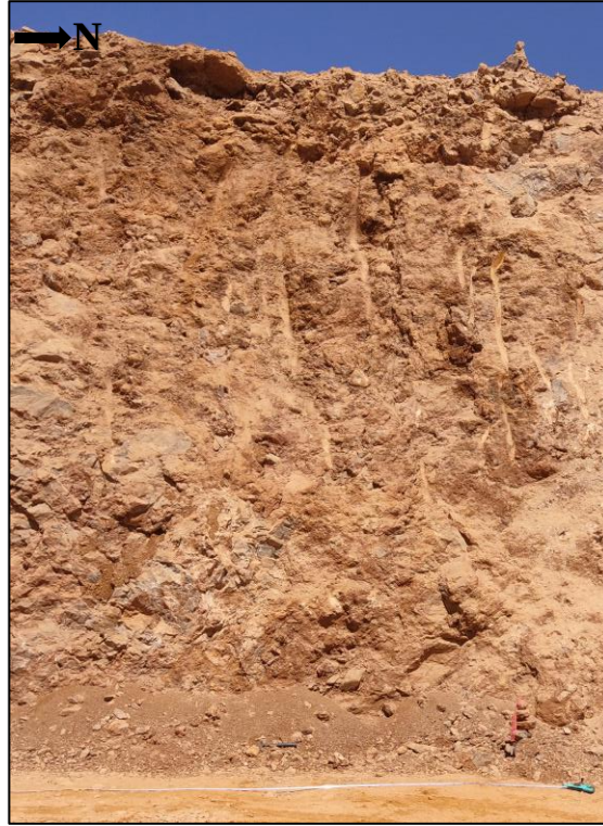
Figura 4.30. Estación C88 en que se observa una mala calidad geotécnica del macizo rocoso.
