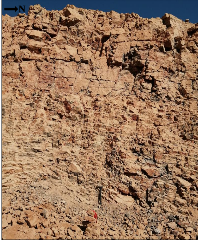
Figura 4.31. Estación C10 en que se observa una calidad geotécnica media del macizo rocoso.
