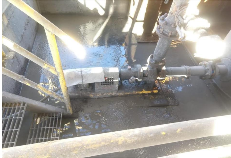
Figura N° 3.15: PP-25. Fuente: Propia.
