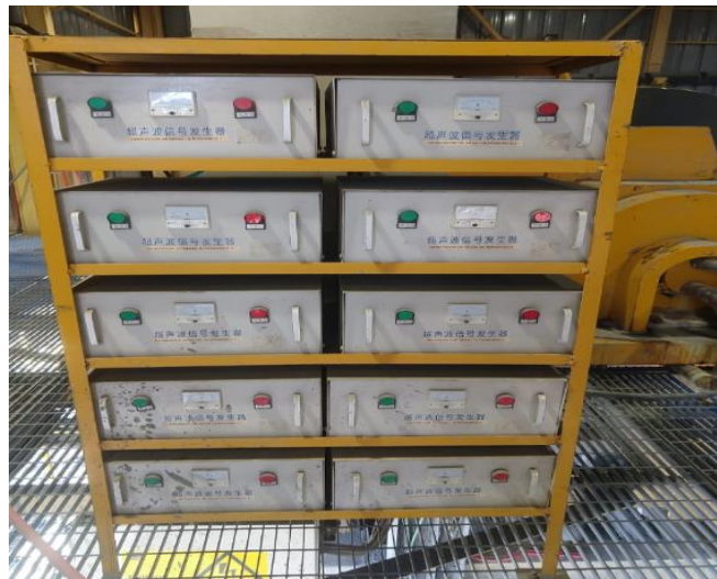
Figura N° 3.14: Lavado ultrasonido independiente filtro 1, 2 y 3. Fuente: Propia.
