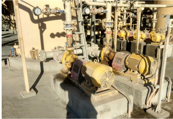
Figura N° 3.9: Planta de relaves filtrados. Fuente: Propia.
