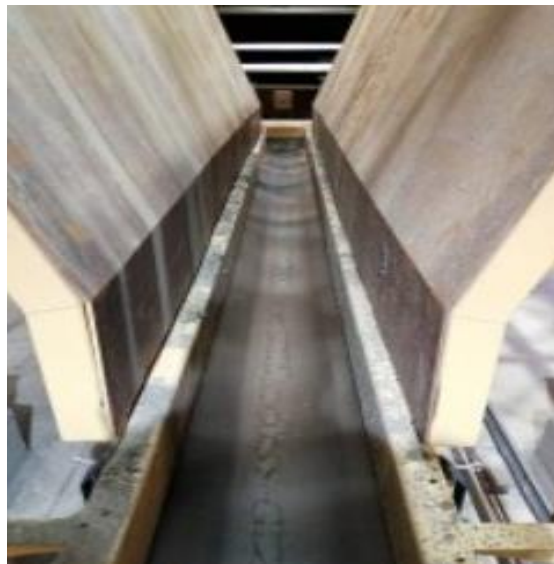
Figura N° 3.19: Descarga de correa transportadora. Fuente: Propia.
