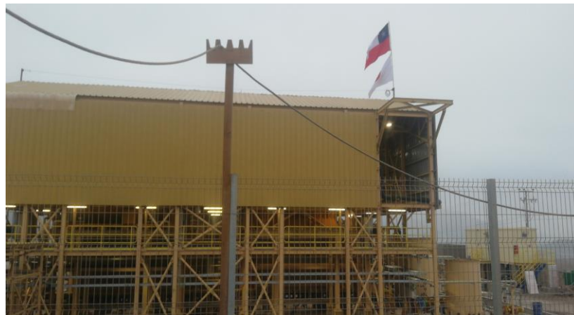
Figura N° 3.3: Ingreso a planta. Fuente: Propia.
