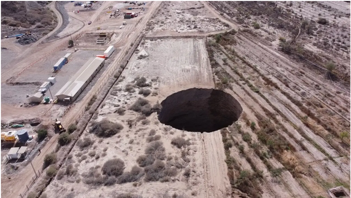
Figura N°2 El enorme socavón en Tierra Amarilla, Chile. FOTO: EFE/Cedidas
