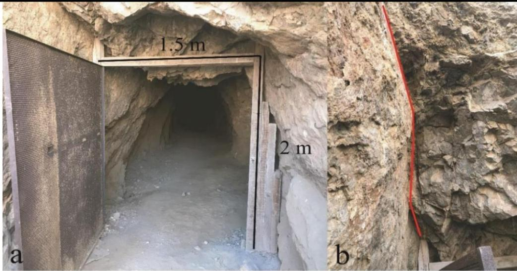
Figura 5.12.5: Imagen extraída de Pérez, 2019. a) Galería principal con puerta rectangular y marco de madera, con unas medidas de 1,5 m de ancho y 2 m de largo. b) Principal veta aurífera de Capote, de ancho milimétrico y una actitud de N30W;40NE (Pérez, 2019).
