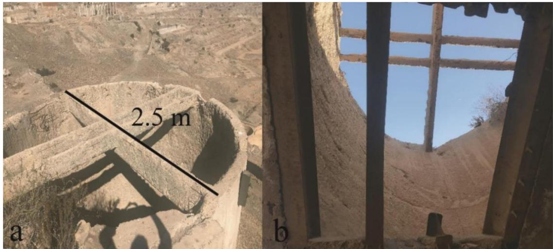
Figura 5.12.4: Imagen extraída de Pérez, 2019. Chancador principal de Capote. a) Vista superior de chancador, con un diámetro de 2,5 metros, construido de concreto. b) Vista interior de la base del chancador, con un alto de 4 metros aproximadamente (Pérez, 2019).
