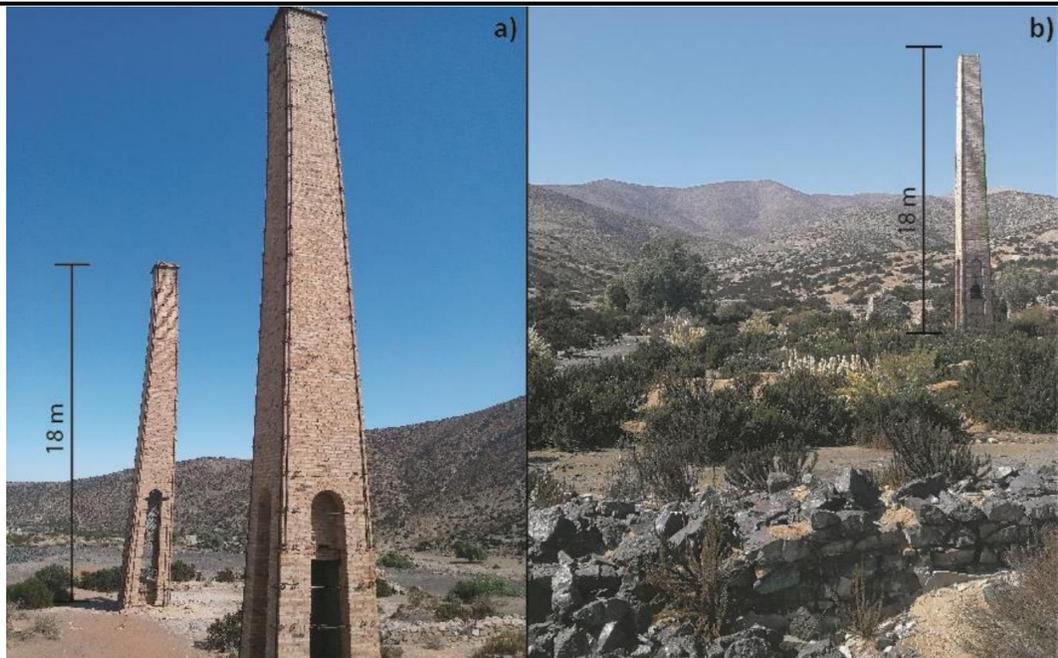
Figura 5.16.6: Chimeneas de Labrar, que funcionaban junto a hornos de reverbero para fundir mineral de cobre, y que eran alimentadas principalmente por el mineral de Quebraditas. a) Dos chimeneas que se encuentran trizadas y curvadas en su parte más alta. b) Tercera chimenea que fue elaborada con bloques de la escoria de la planta (Costa, 2019). Imagen extraída de Costa (2019).
