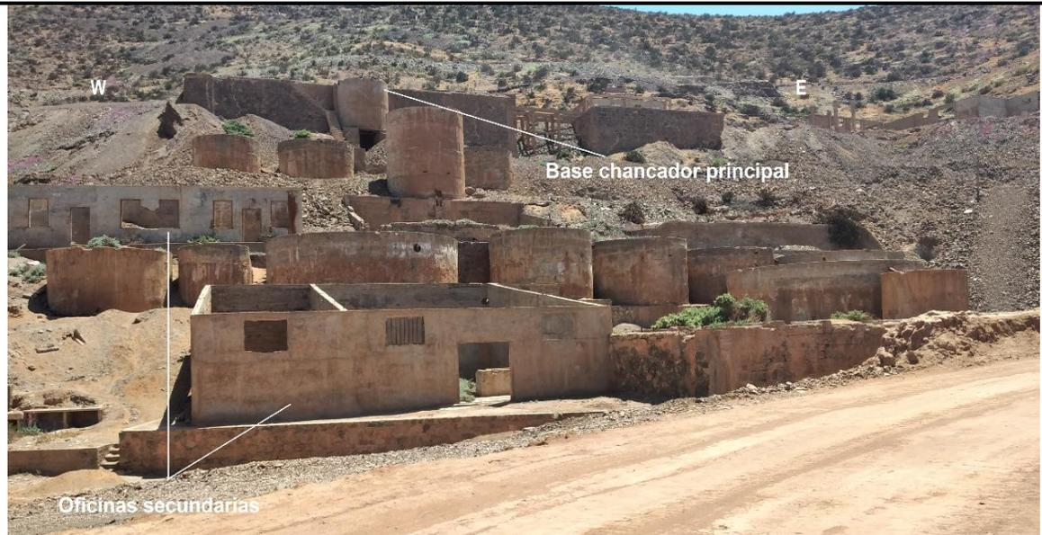
Figura 5.12.3: Vista frontal de planta de procesamiento de cianuro. Se identifica la base del chancador principal, cilindros y dos oficinas secundarias.
