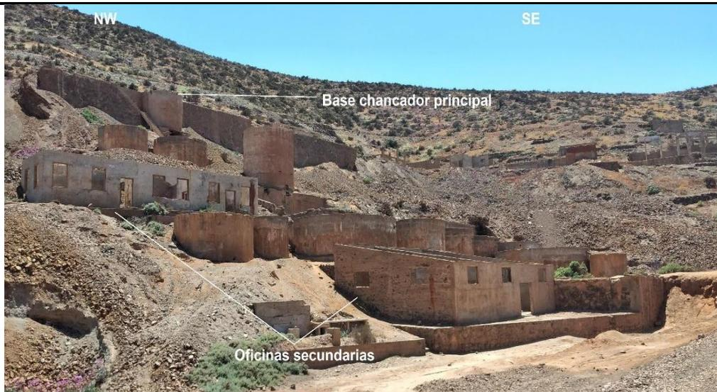
Figura 5.12.2: Vista lateral de planta de procesamiento de cianuro. Se identifica la base del chancador principal, cilindros y dos oficinas secundarias.
