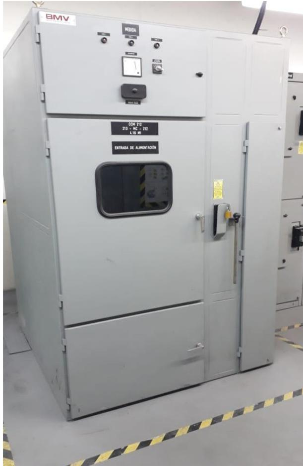
**Figura N° 3.6: Compartimiento de entrada del CCM 212.**
