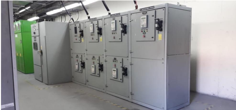
**Figura N° 3.5: Configuración actual del CCM 212 sin compensación reactiva.**
